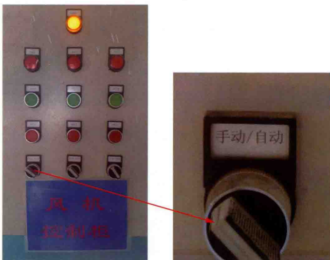
图4-10 风机控制柜的手动状态
