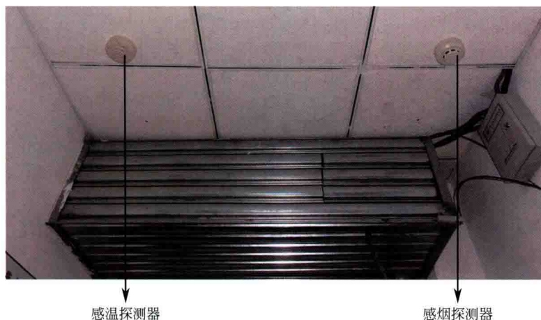
图3-4 卷帘一侧的感烟、感温探测器
