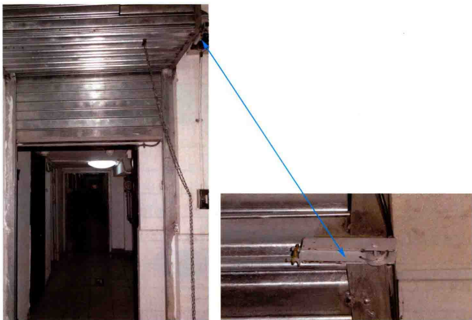
图3-5 熔断装置
