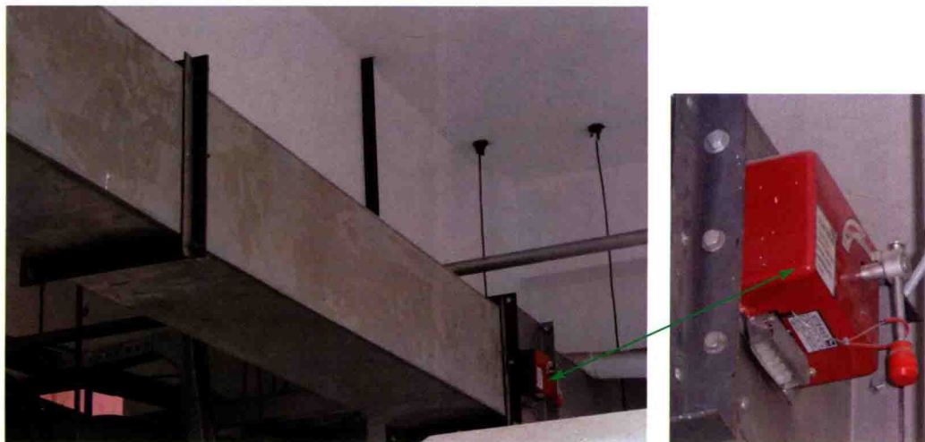
图4-4 正压送风系统防火阀
